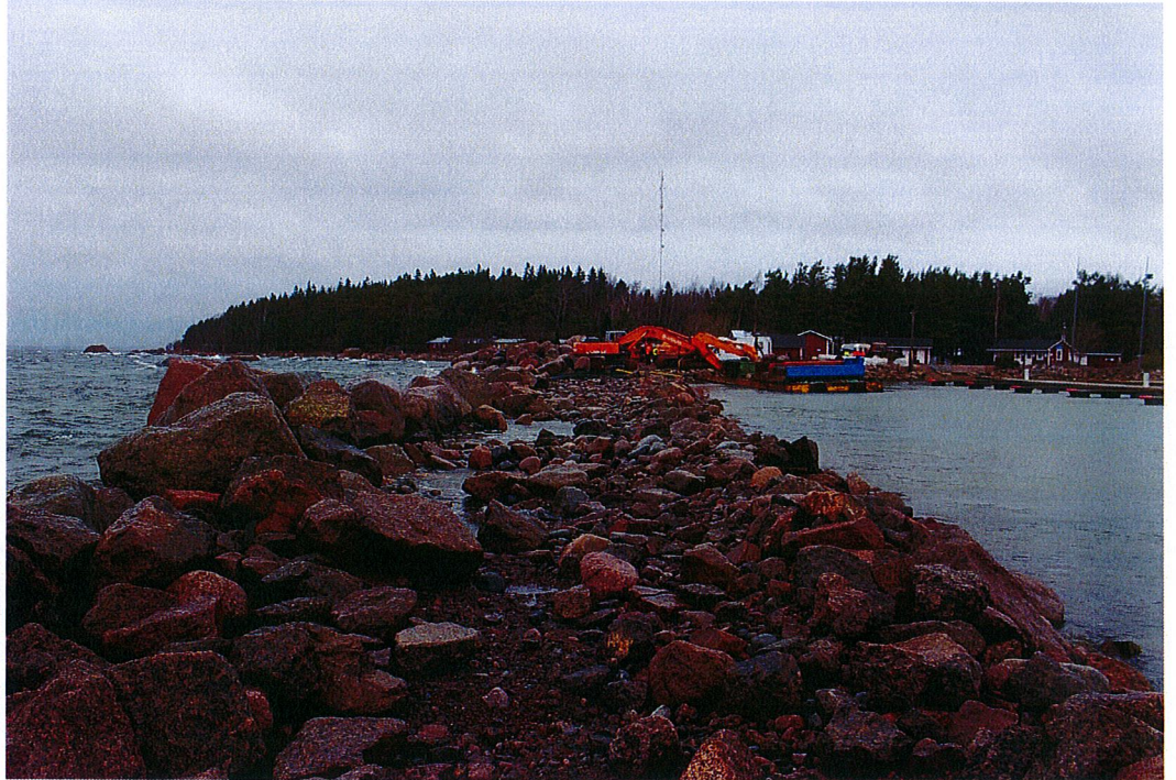
Aallonmurtajan pitkäsivu kuvattuna puolivälistä pohjoiseen
