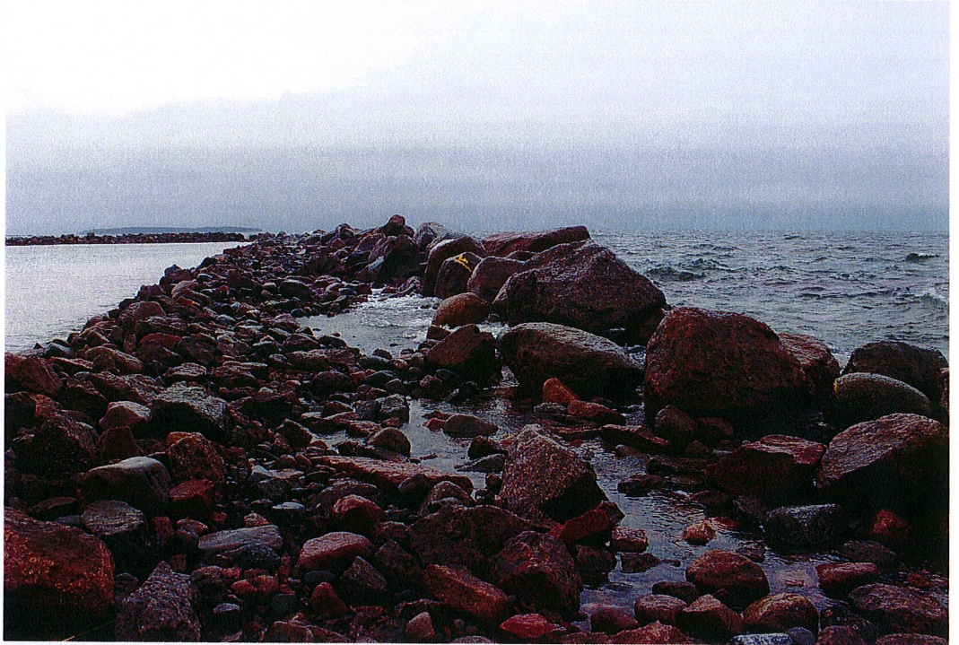
Aallonmurtajan pitkäsiivu keskeltä kuvattuna etelään
