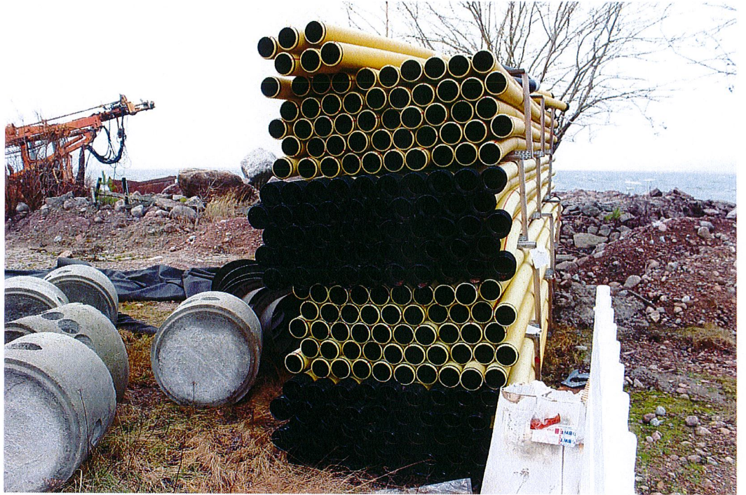
5. Tekniikkaputket (PE TUPLAKAAP 110/95 SN 16/A 6m KELT) 206 kpl yht. 236 metriä.
