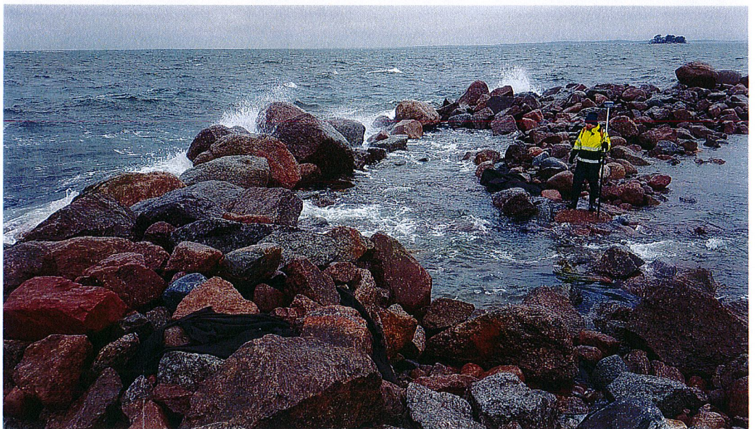
Aallonmurtajan putka kuvattuna lyhyen sivun juuresta länteen
