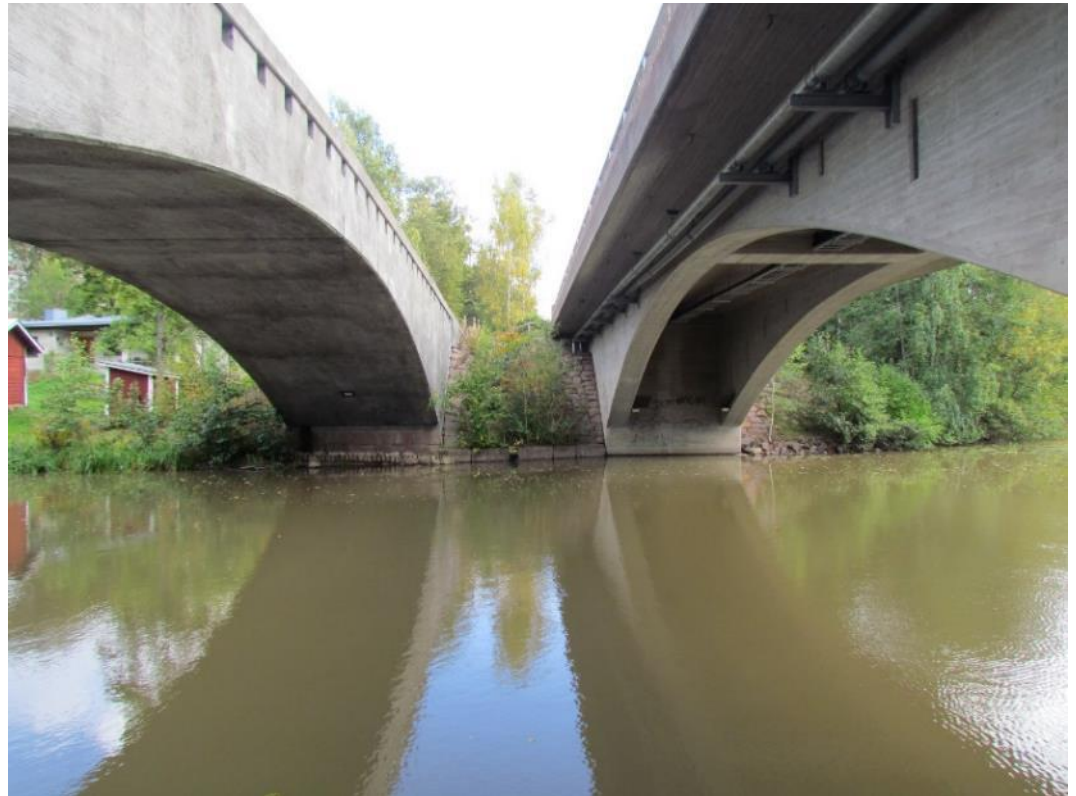
Kuva 4. Vasemmalla (pohjoisessa) kevyenliikenteen siltana toimiva vuosina 1922-1923 rakennettu betonisilta. Oikealla nykyinen maantiesilta.
