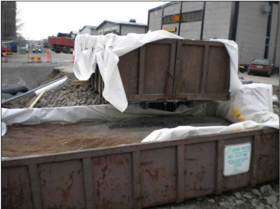
Kuva 10. Esimerkkikuva vaihtolavan sisään rakennetusta suodattimesta. 4
